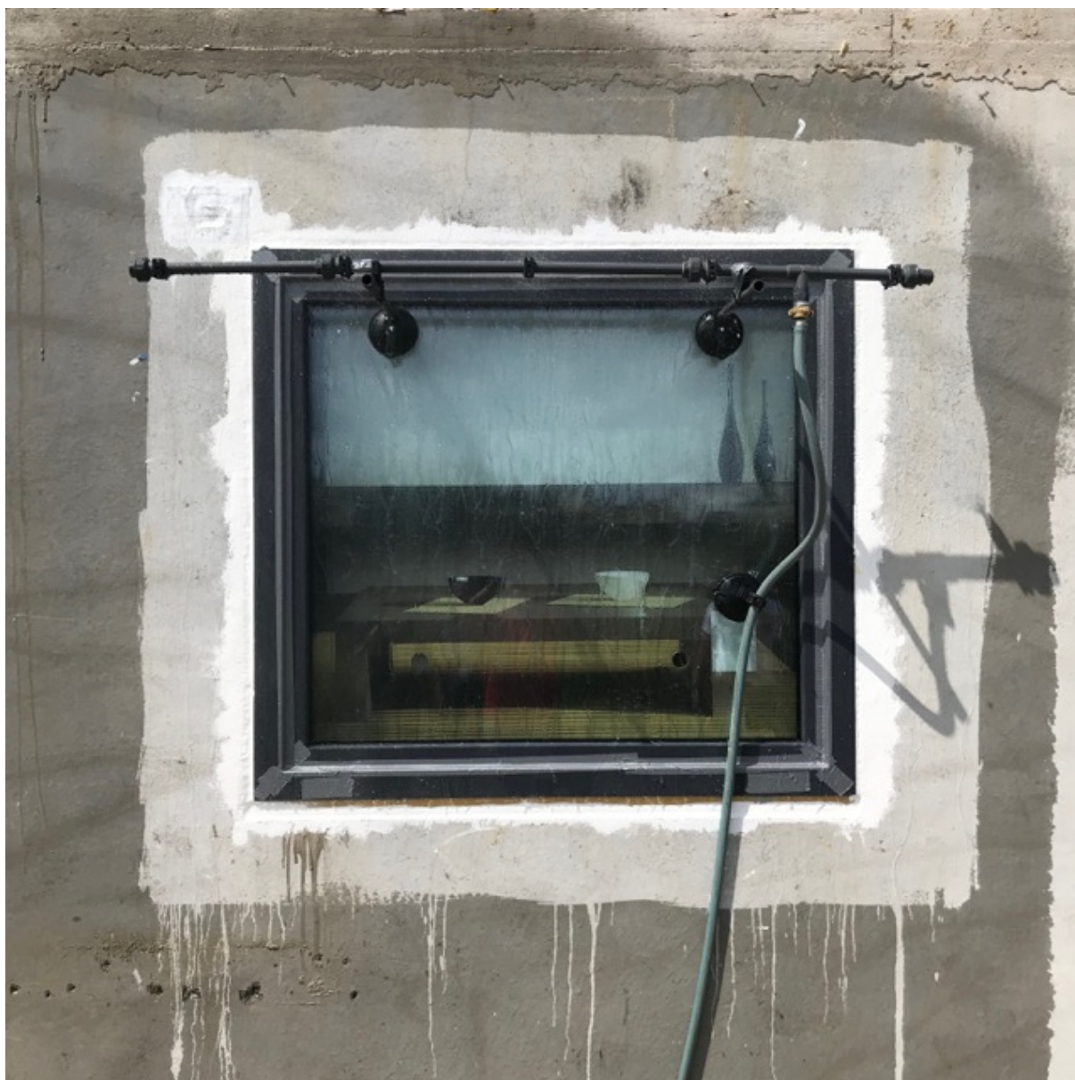
Fot. 9 Widok od strony zewnętrznej zaklejonego okna.
